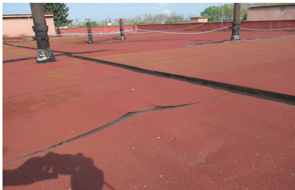
Detailní pohled na zvlněnou krytinu. Celkový stav střšní krytiny lze zhodnotit jako dožilý.
