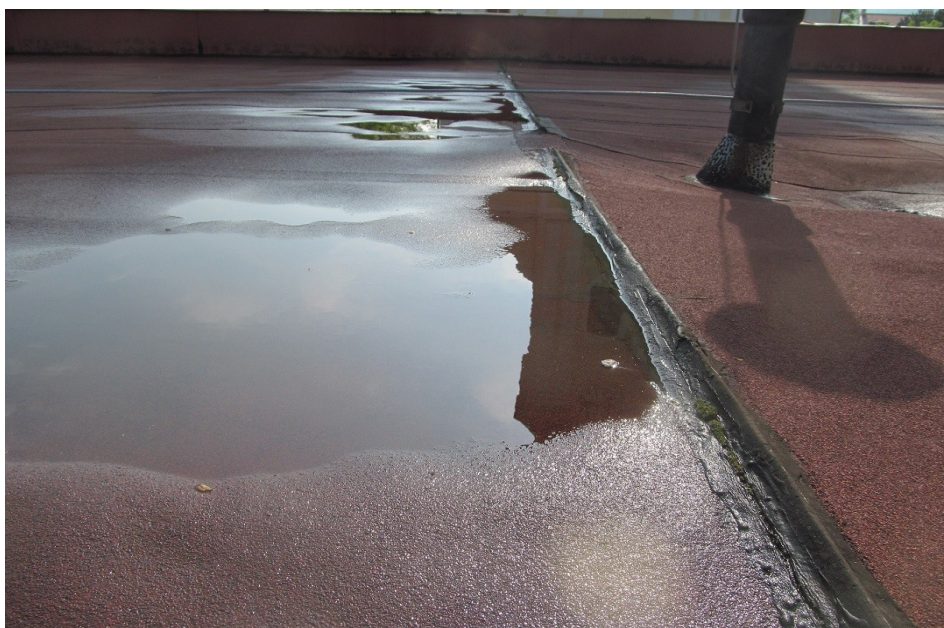
Detailní pohled na střechu. Kaluže vody signalizují nedostatečný spád střechních rovin pro optimální odvod srážkové vlhkosti. Sklon střechních rovin je 1-2°, místně není sklon žádný, nebo dokonce i opačný.
