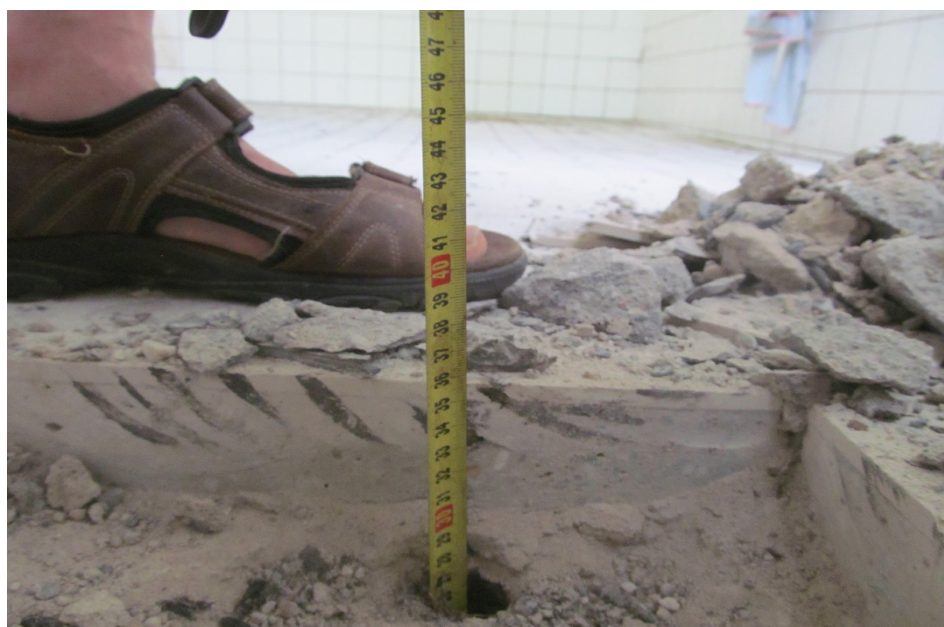
Celková tloušťka konstrukce je cca 350 mm.
