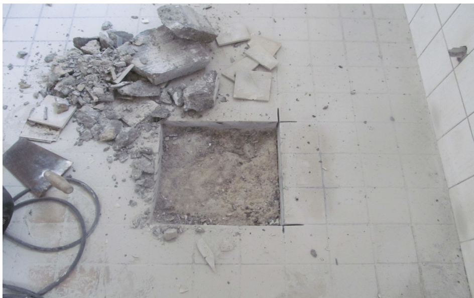
Sonda do konstrukce stropu nad 1NP v místě kuchyně.
